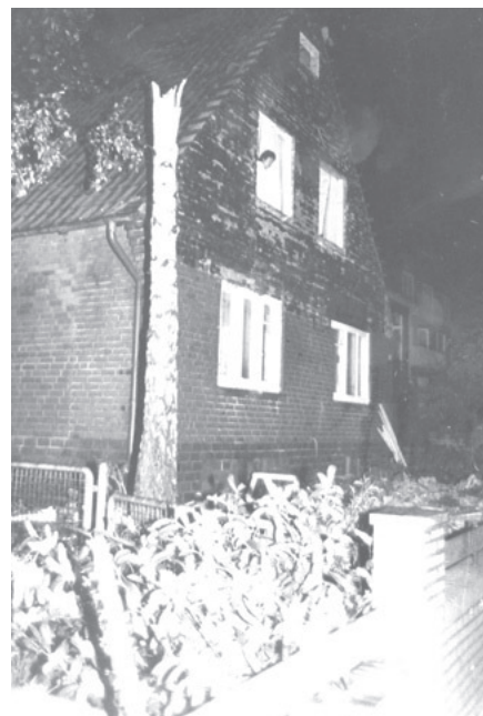
21. Mai 1983: Sturmschäden Eckernförder Str. 274
