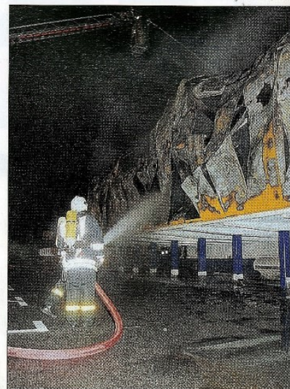
Endphase der Brandbekämpfung im Bereich des Aerobicstudios.
