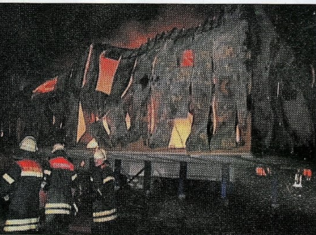
Das ausgebrannte Aerobicstudio. Die Blechverkleidung hatte sich durch die Hitze verformt und drohte abzustürzen.
