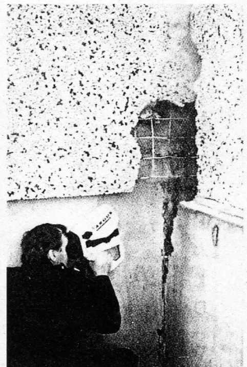
5 Einsatz der Wärmebildkamera
