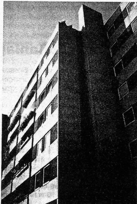
1 Teilansicht des Gebäudes, in dem Winkel ist der Schornstein über der Heizzentrale zu sehen.
