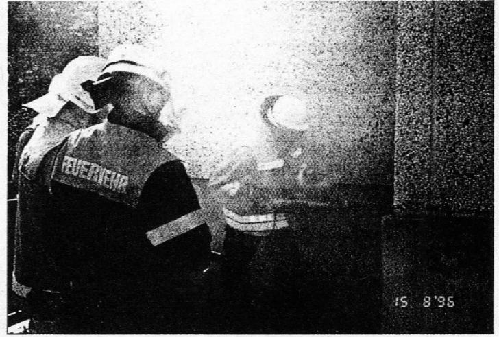
3 Aufstemmen der Wand, um an den Brandherd heranzukommen ...
