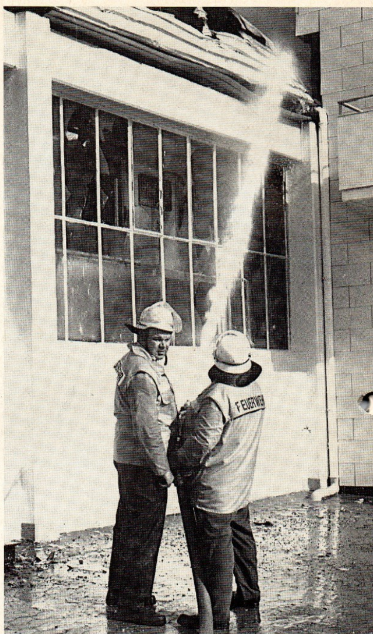
Schutz des Wohn- und Bürogebäudes.
